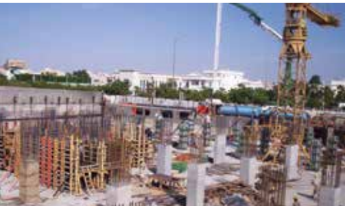
Estacionamiento Subterráneo en Hospital Privado Al Mashfa, Jeddah, Arabia Saudita
