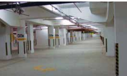
Estacionamiento Subterráneo KK Times Square Kota Kinabalu, Malasia
