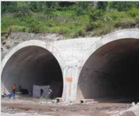
Trabajo de reparación de los Túneles Yunnan Shuima
