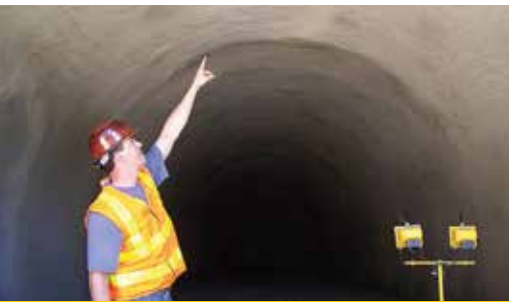
Túnel Peatonal Teatro Knight, Charlotte, Carolina del Norte, USA
