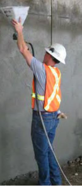
Krystol T1 reduce la permeabilidad del concreto y lo protege contra el ingreso de agua y materiales químicos hidrosolubles. Dado que se convierte en parte integral del concreto, puede ser aplicado por lado positivo (húmedo) o por el lado negativo (seco), lo que permite tener una protección impermeabilizante confiable, aún en las condiciones de aplicación más difíciles.
